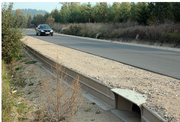
Fot. 2. Przejście pod szosą dla płazów
