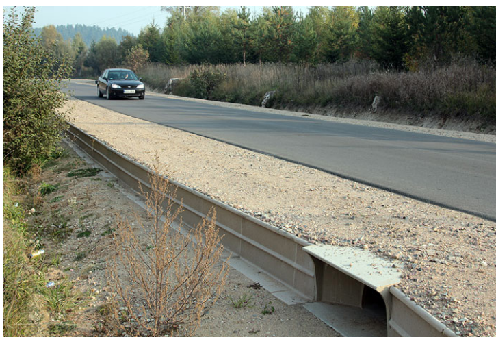
Fot. 2. Przejście pod szosą dla płazów
